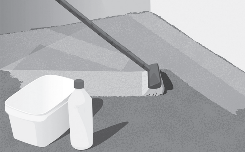
Kuva 7. Puhdista ja pohjusta lattia.
