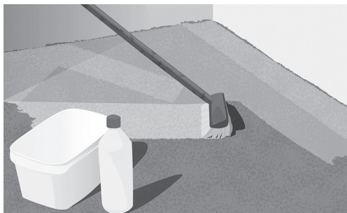
Fig. 7. Rengør og forbehandl gulvet.
